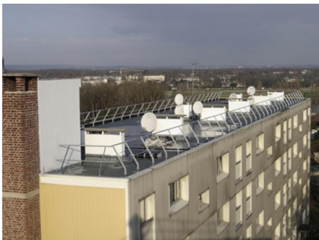
parapetto permanente autoportante fisso su copertura piana
